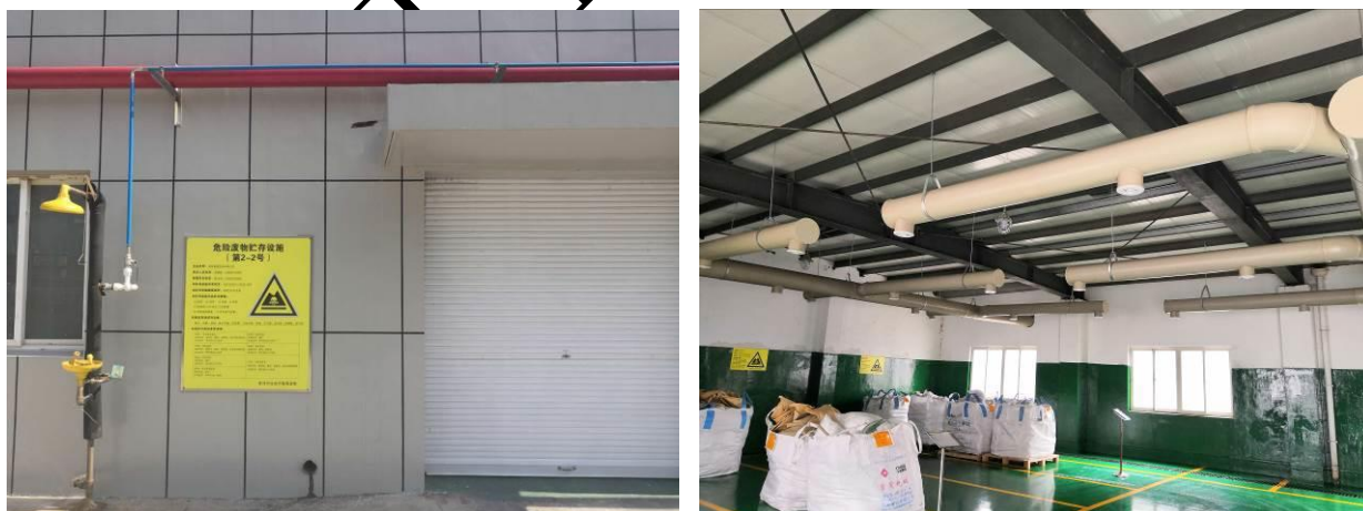
图 2.2-5 厂内危险废物仓库现场照片
